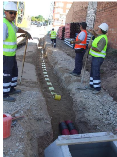
Canalización UA-14, Arahal.
