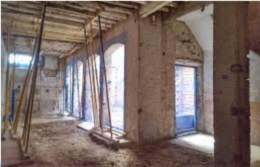
Rehabilitación Edificio Catalogado Sevilla.
